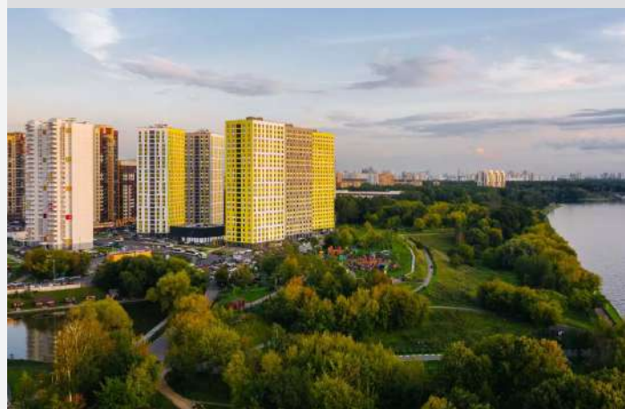
ЖК «Левобережное», г. Москва
